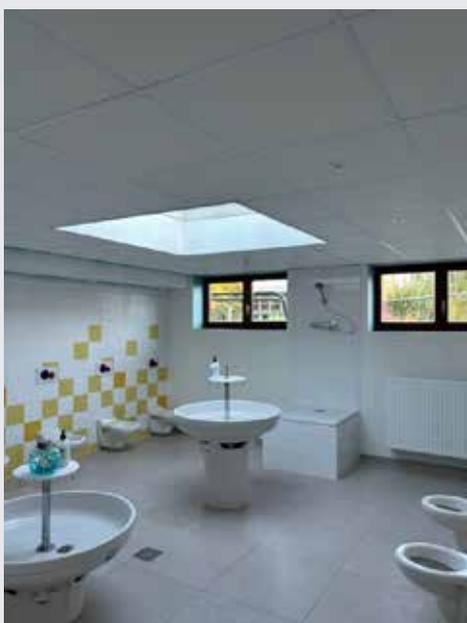
La rénovation complète des sanitaires de l'école Pasteur a été réalisée pour la rentrée scolaire de Toussaint. Les problèmes de contre-pente, de ventilation et d'odeur sont donc résolus. Dalle, réseaux sous dalle, plomberie et électricité ont été entièrement repris. La commune a opté pour des luminaires Led associés à des détecteurs. L'isolation a été renforcée, et les vieux skydomes ont été remplacés par des puits de lumière.
